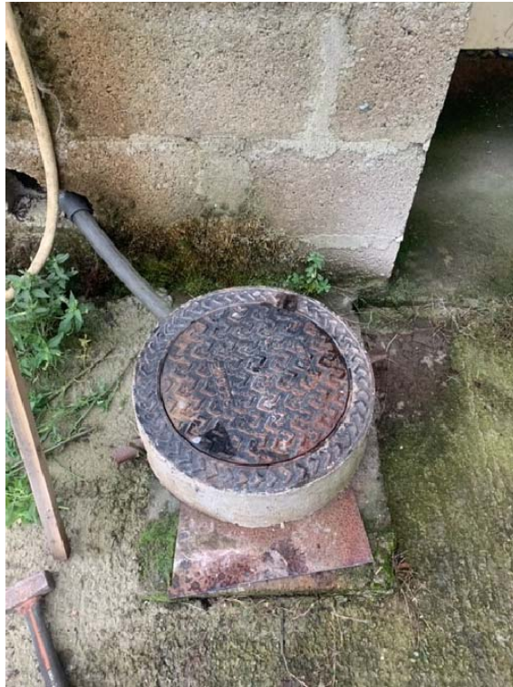
PHOTO 5 : protection de la tête de forage
