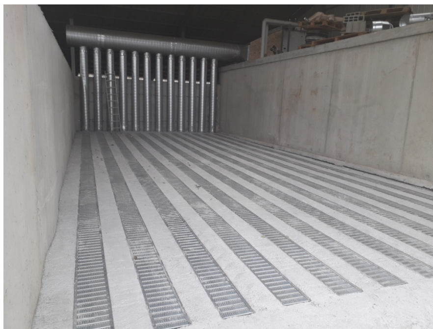
PHOTO 3 : cellule de séchage de fourrages (GAEC DES PINS)
